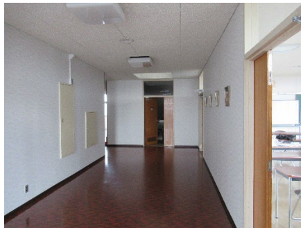
2階廊下 天井・照明は落ちてないか。 壁は落ちてないか
