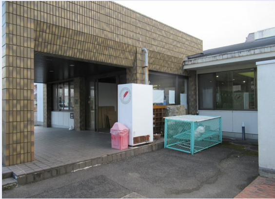
① 外観：外壁の落下、窓ガラスの割れはないか、大内社会福祉センター周囲を確認
