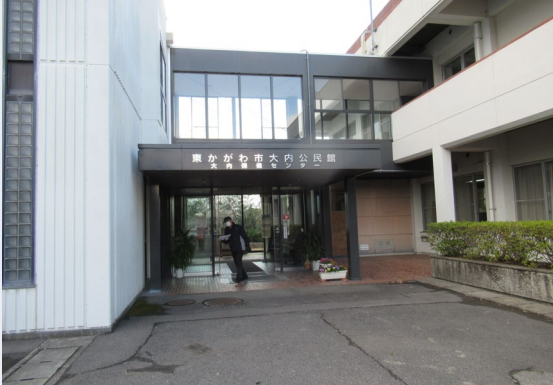
①外観：外壁の落下、窓ガラスの割れはないか、大内公民館周囲を確認
