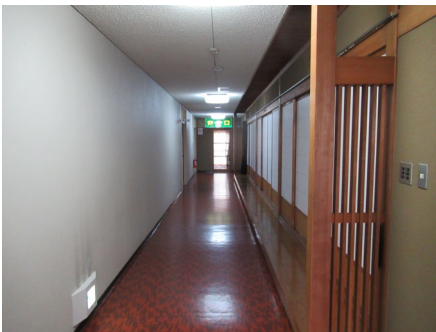
1階の中廊下 照明、壁は落ちていないか 天井は落ちていないか 出口は開くか。ガラスは？
