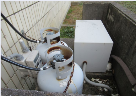
③ガス臭くないか ボンベが転倒していないか ガス臭い場合はボンベのバルブを閉める
