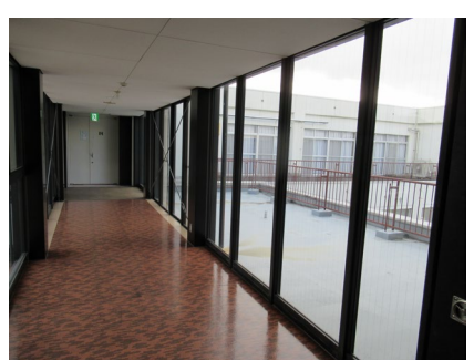
2階渡廊下 天井・照明は落ちてないか。 ガラスは壊れて落ちてないか
