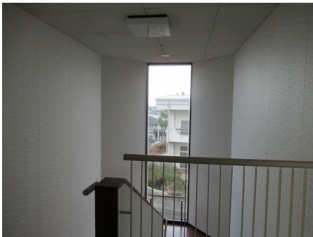
1 階→2階階段 天井・照明は落ちてないか。 ガラスは壊れていないか。 階段手摺りは壊れてないか
