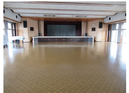
2階ホール 天井は落ちてないか。 照明、クーラーは落ちてないか ガラスは壊れていないか。
