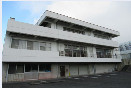
④地階は崩れていないか
